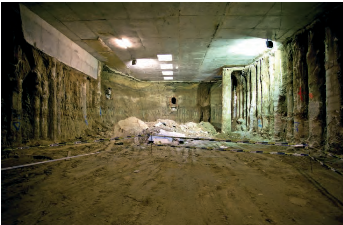
Bajando a un tunnel de una reciente excavación en Madrid, 2010. Photo: Alfonso Herraz. Courtesy: Ellen de Bruijne Projects.
