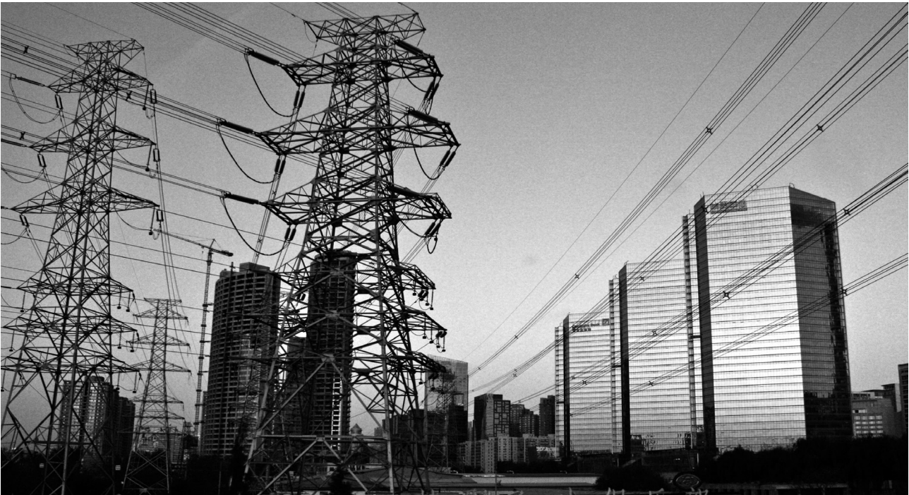
Tendido eléctrico en Pekín con varios edificios en construcción al fondo.
