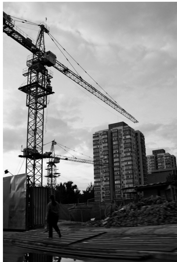
Edificios en construcción en Pekín.
